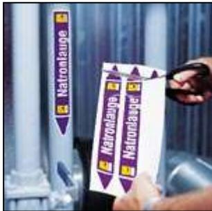
1. Bei den Einzelmarkierern entfernen Sie die nicht benötigte Pfeilspitze um so die Fließrichtung zu kennzeichnen.
