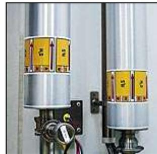
3. Kleben Sie den Markierer auf das Rohr. Wenn sich die beiden Enden der Rollenmarke überlappen, erreichen Sie eine noch bessere Haftung.
